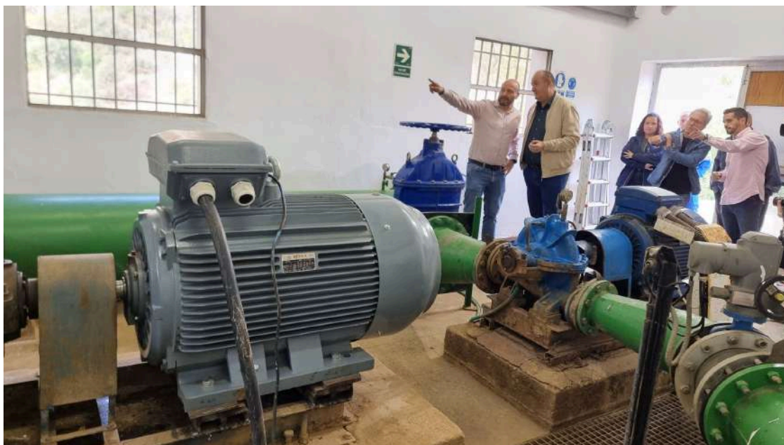
Visita del teniente de alcalde de Medio Ambiente de Valdepeñas para conocer las inversiones en el pantano de Fresnedas para mejorar la calidad del agua / Ayuntamiento de Valdepeñas
