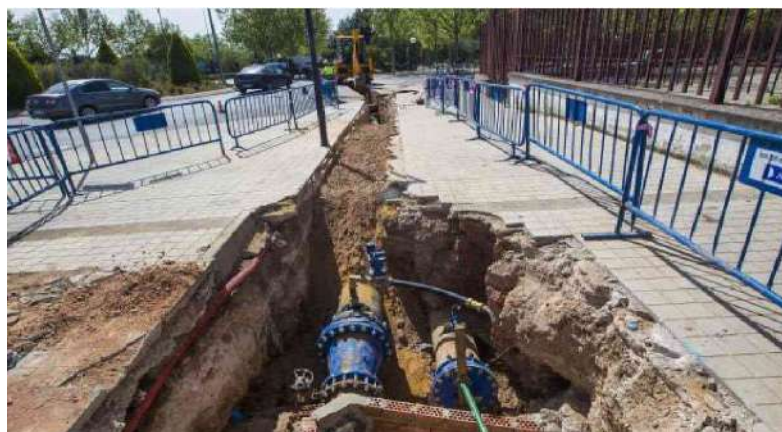
Imagen de archivo de unas obras de infraestructuras hidráulicas. / RUEDA VILLAVEDE
